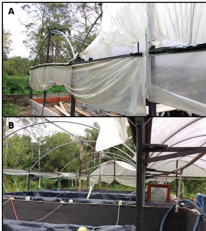
**Figura 3:** Resultado do vendaval que danificou a estrutura da estufa onde seria realizada a etapa experimental deste projeto. Imagem A: Vista externa. Imagem B: Vista interna.
